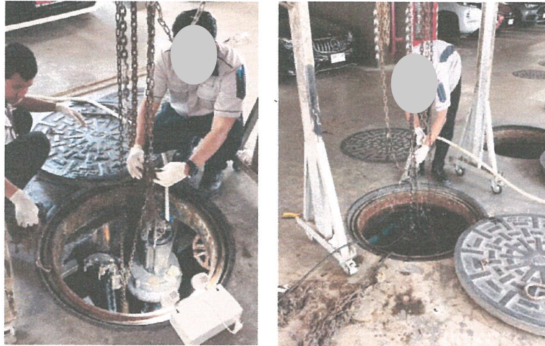
รูปภาพที่ 2.28 การตรวจเช็คระบบบำบัดน้ำเสีย
