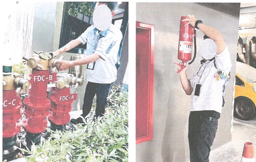
รูปภาพที่ 2.37 การตรวจสอบอุปกรณ์ป้องกันและแจ้งเตือนอัคคีภัย
