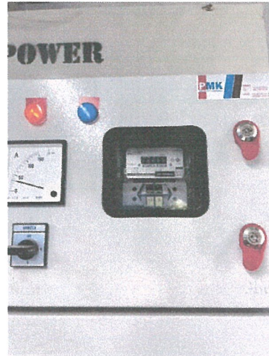
รูปภาพที่ 2.41 มิเตอร์ระบบบำบัดน้ำเสีย
